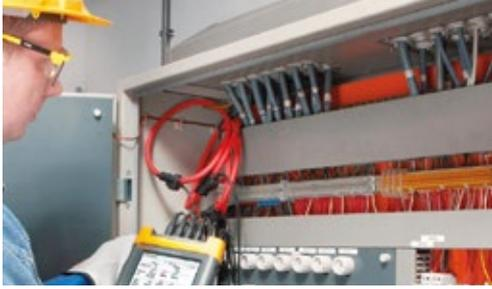
Die Experten der Ingenieurbüros führen die Abnahmeprüfungen mit Netzanalyse durch.
