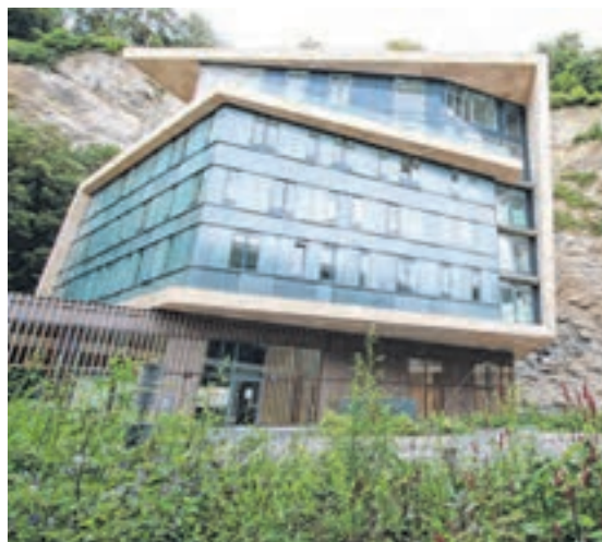
Bauen mit und am Felsen – Projektumsetzung in Salzburg. © Karin Standler
