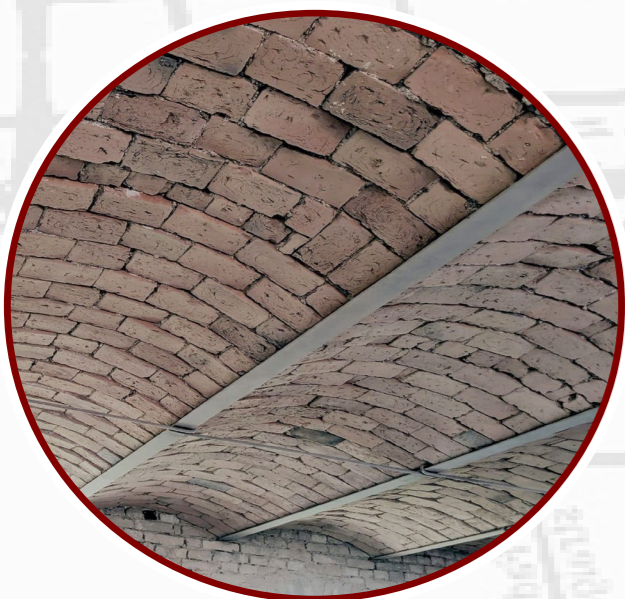
brick slab Preussische Kappendecke
